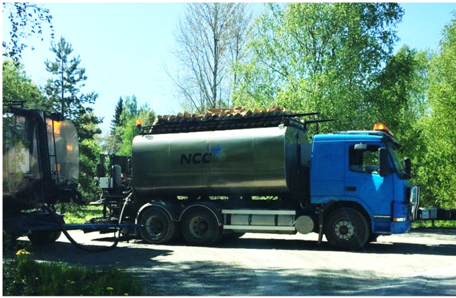
Ny vägbeläggning på gång...
